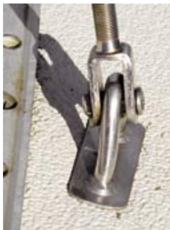
Der er ofte utæthed ved røstjernene og dette ser også ud til at være tætnet og laminatet trykket sammen.
